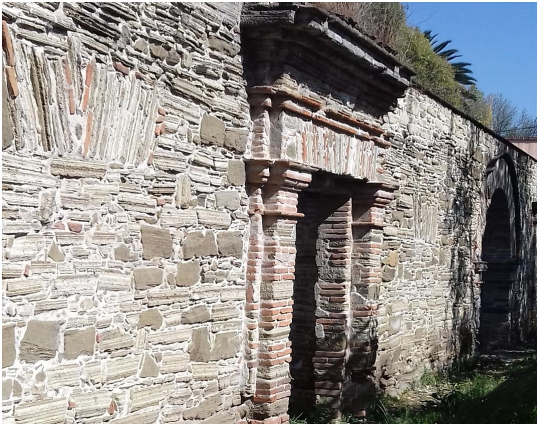
Vestigios de la iglesia de San Sebastián, confundida con el hospital de “la Encarnación”, cuyos muros de xalnene grueso muestran las diferentes capas sedimentarias que forman cada piedra / Ivings 2023
