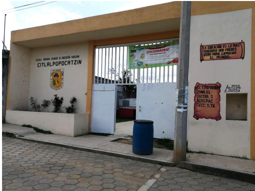
Figura 5.7. Fachada de la Escuela primaria Citlalpopocatzin
