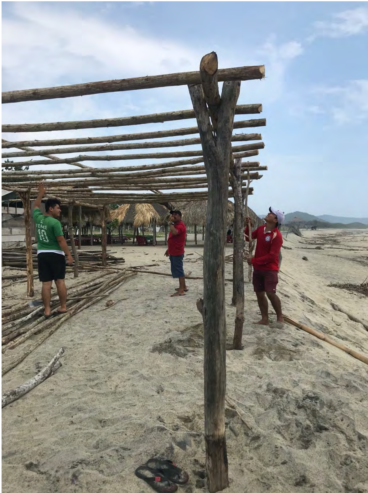
Fotografía 16. Construcción de enramada
